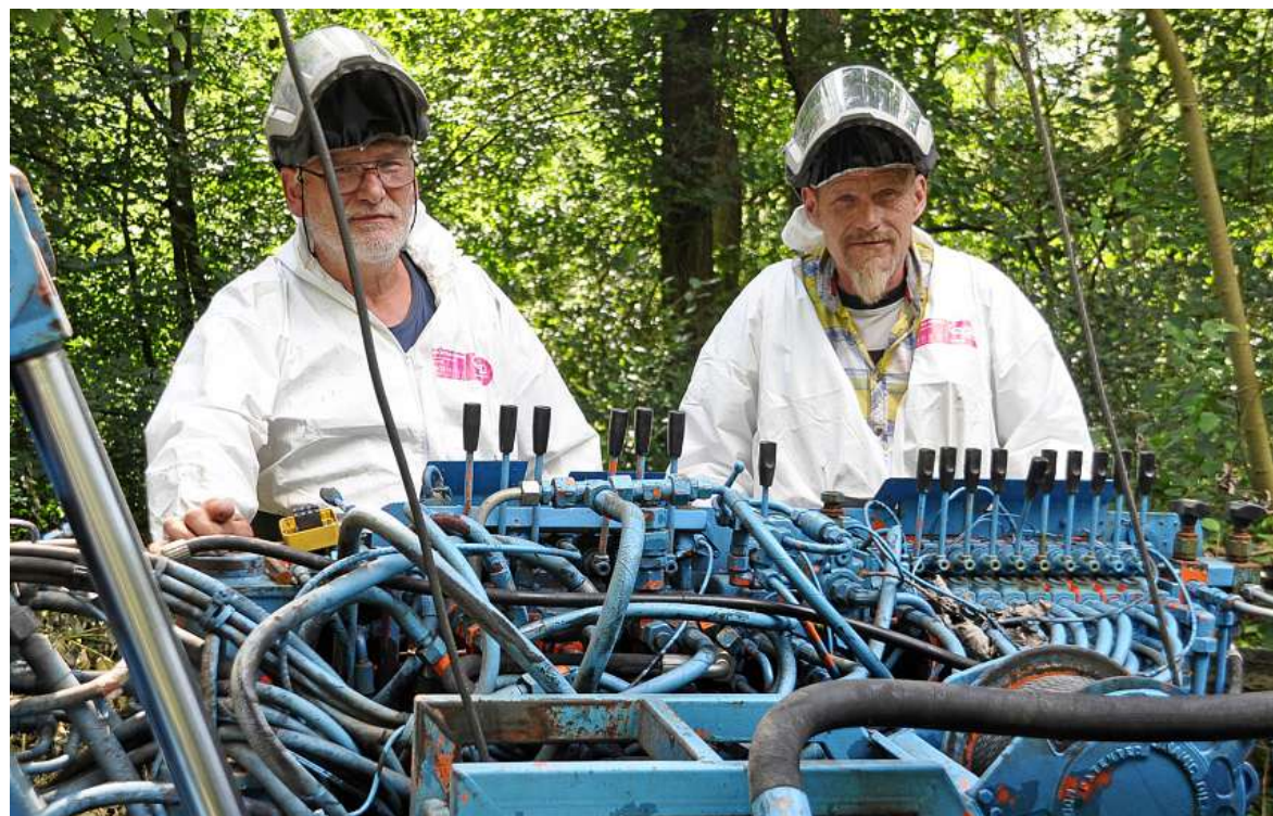
Bohrmeister Stefan Bruhn (re.) und Helfer Norbert Drube durchlöchern den Boden maschinell. FOTO: VOIGT
